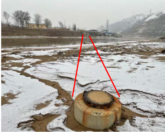
污水处理厂西侧管道穿越河流处
