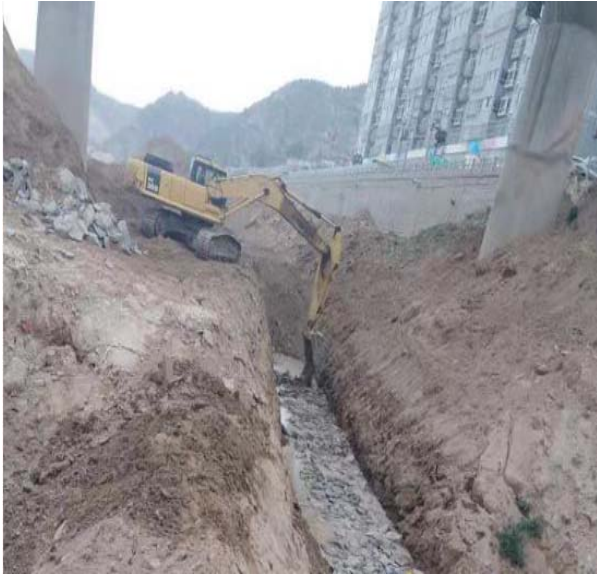
项目施工期基槽开挖
