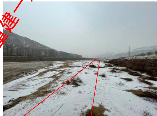
污水处理厂北侧管道临时占地恢复情况
