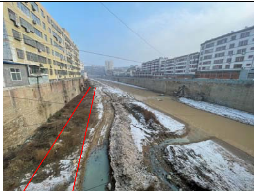
南关桥南侧管道临时占地恢复情况
