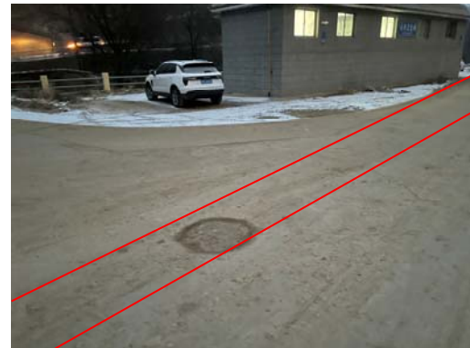
道路临时占地恢复情况
