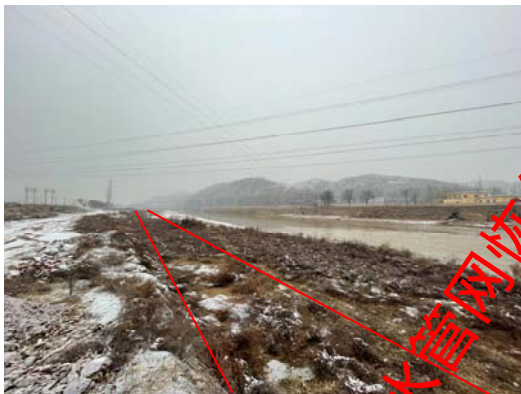
污水处理厂西侧管道临时占地恢复情况
