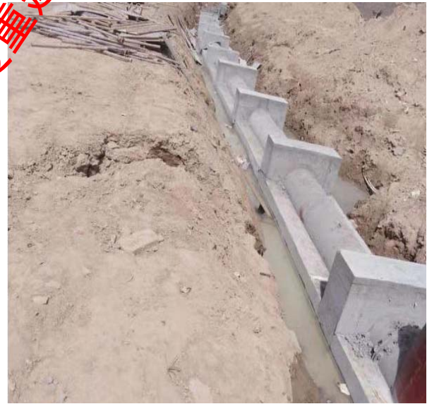
项目施工期拆模后
